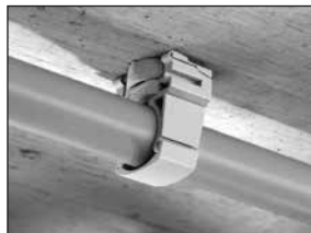
Cable conduits or light duty pipes
