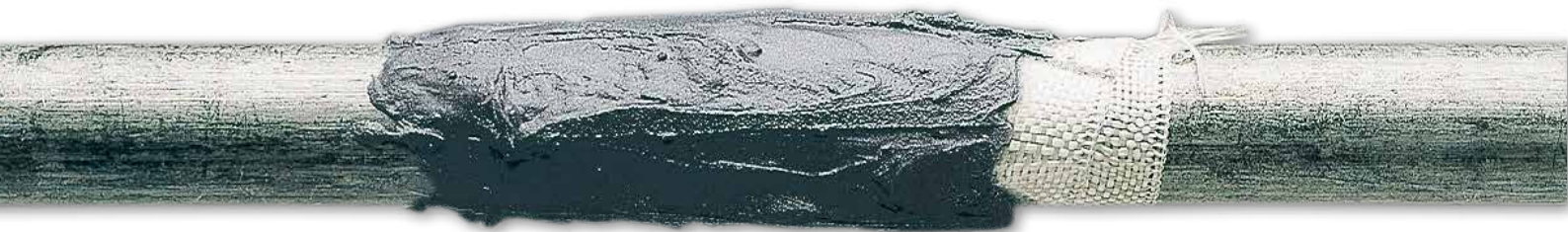
تعمیر اضطراری یک لوله آب
